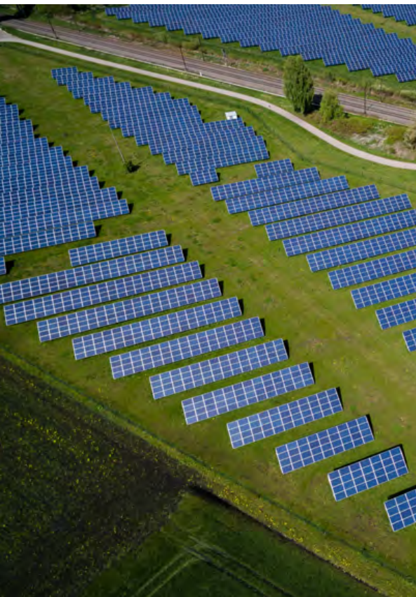
Solarpark in Offingen, Deutschland. Die Energiewende nimmt Fahrt auf.
